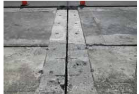
2. 既設舗装、床版、旧伸縮装置の撤去完了
