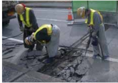
1. 既設伸縮装置の撤去
