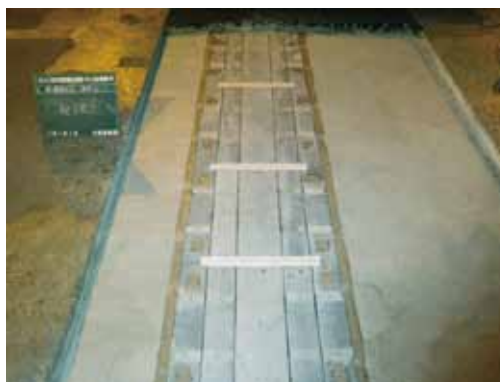
設置完了(舗装前状況)
