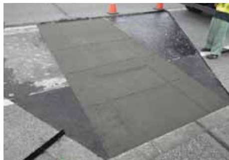
7. ひび割れ抑制シートの貼り付け
