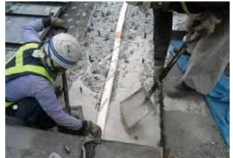
4. 樹脂モルタル(JH-3モルタル)の打設
