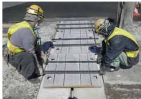
5. 連続化装置の設置
