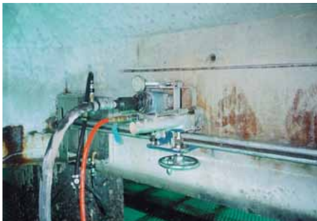
①カッター設置状況
