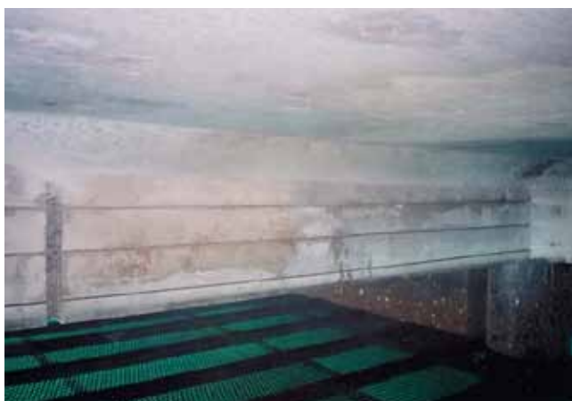
②カッター工完了
