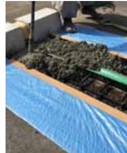
▲ 裏込め材打設
