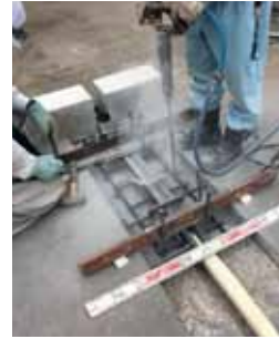
▲ コンクリートアンカー設置
