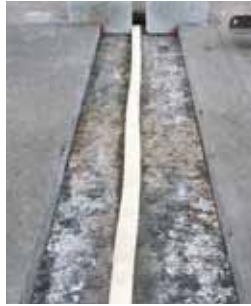
▲ 既設伸縮装置撤去
