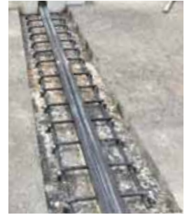
▲ 伸縮装置設置完了
