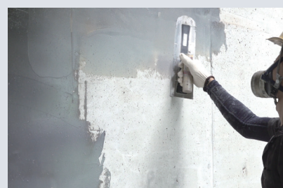
▲ネオプライマーEX Plus+ 施工状況
