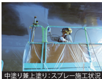
中塗り兼上塗り：スプレー施工状況
