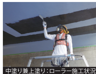
中塗り兼上塗り：ローラー施工状況
