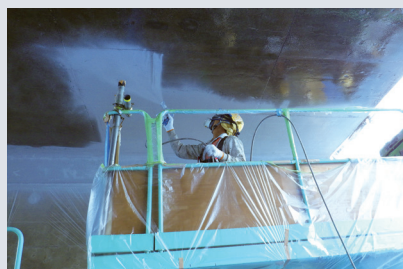
▲ネオライナーEX 施工状況
