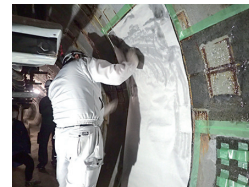
④ シート貼付け・ 接着剤含浸
