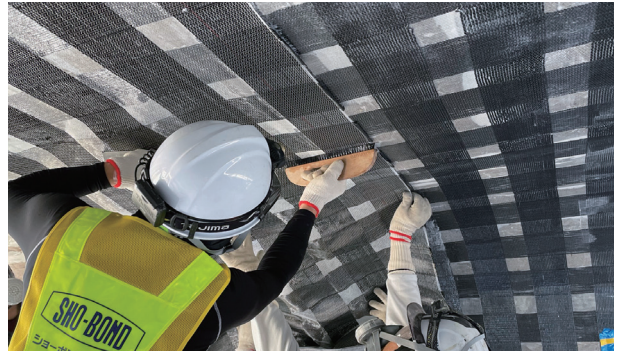
④シートの貼り付け
