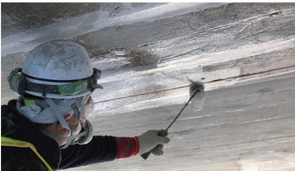
②プライマー塗布
