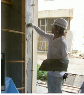
1. 下地調整状況
