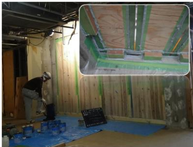
4. エポキシ樹脂注入状況
