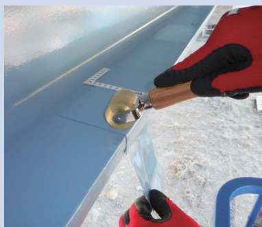
▲ RACタッチ貼付け状況
