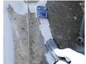
▲取付けパイプの接着とシーリング
