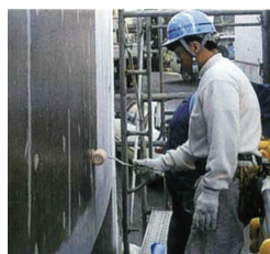
プライマー塗布
