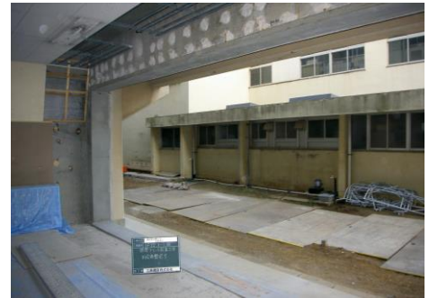
下地調整完了
