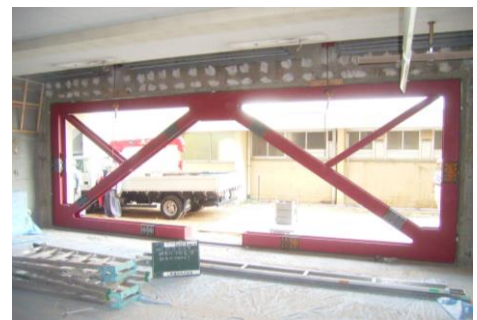
鉄骨建方完了
