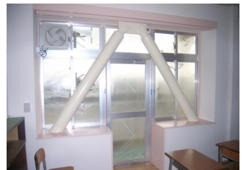
完 成(出入口開口付)
