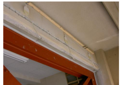
注入樹脂のオーバーフロー状況
