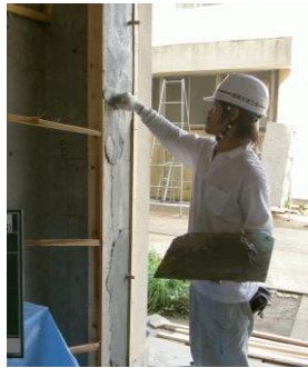
下地調整状況
