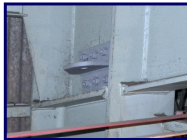
1. 定着金具取付(ボルト接合)
