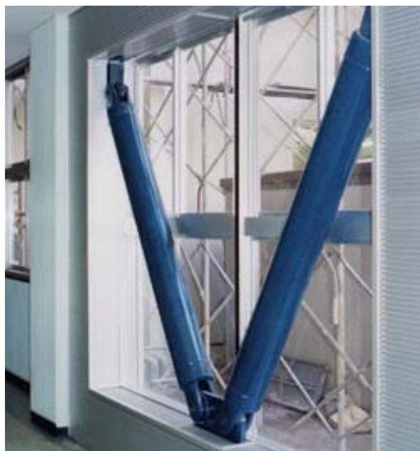
校舎、教室・鉄骨ブレース、クレビス管工事
