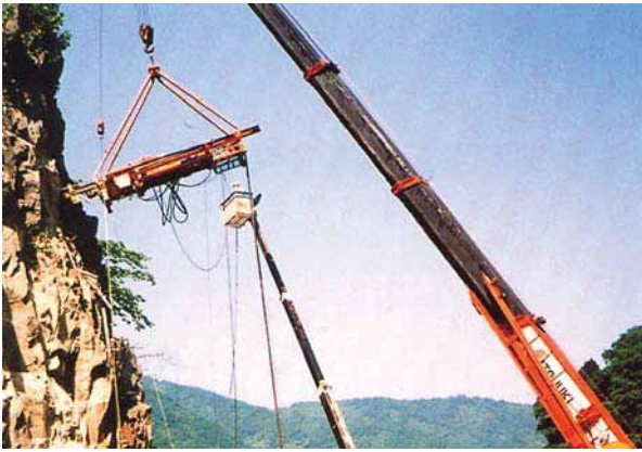
④ 岩盤補強 (ロックボルト)
