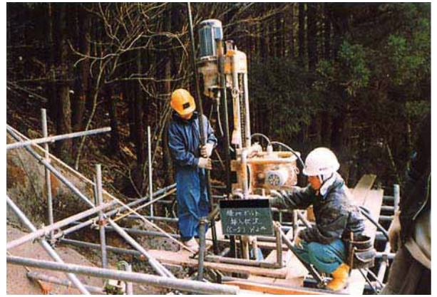
⑥ 斜面对策工 (縫地工法)
