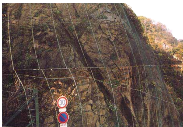
① 岩亀裂補修 (エポキシ系注入材/無機系注入材)
