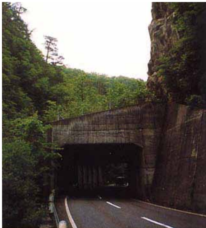
⑤ 洞門対策工 (サンドイッチ工法/耐震補強工)
