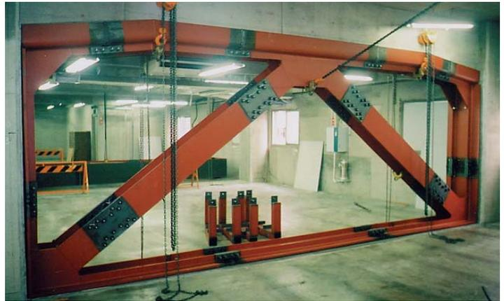
鉄骨ブレース工法( 接着工法 )
