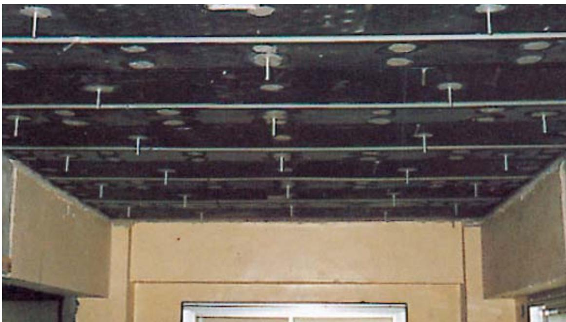
スラブ下面の鋼板接着補強
