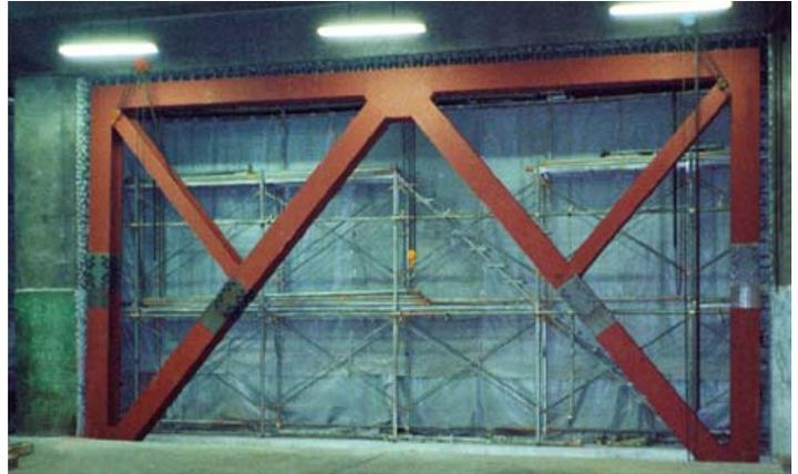
鉄骨ブレース工法( 在来工法 )
