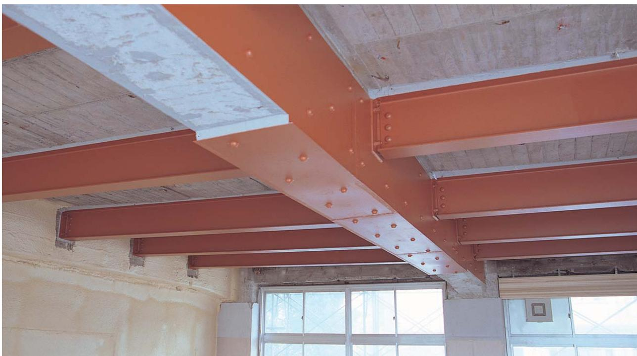
小梁増設補強工法による床補強と大梁の鋼板接着工法
