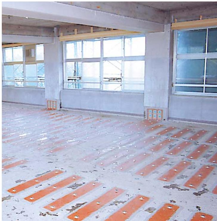
スラブ上面の鋼板接着補強
