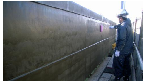
▲ プライマー塗布
