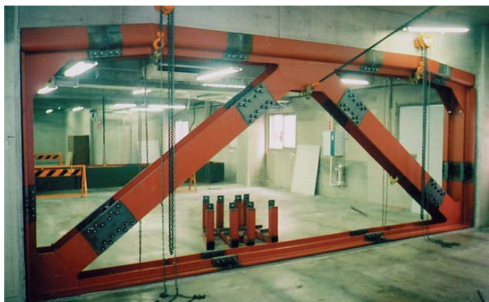
鉄骨ブレース工法(接着工法)
