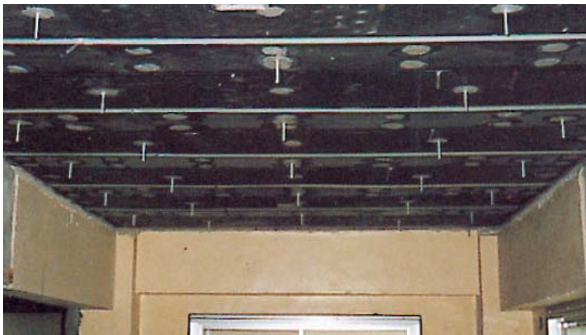
スラブ下面の鋼板接着補強
