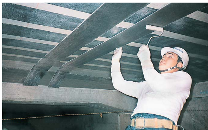
スラブ下面のカーボン繊維シート接着補強
