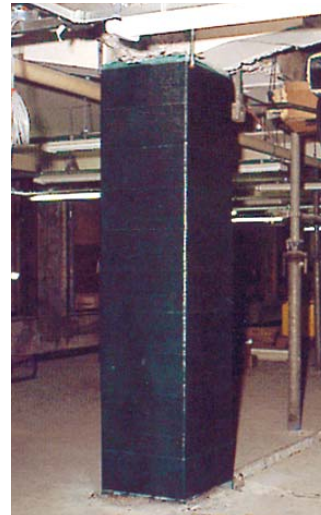
② カーボン繊維シート補強
