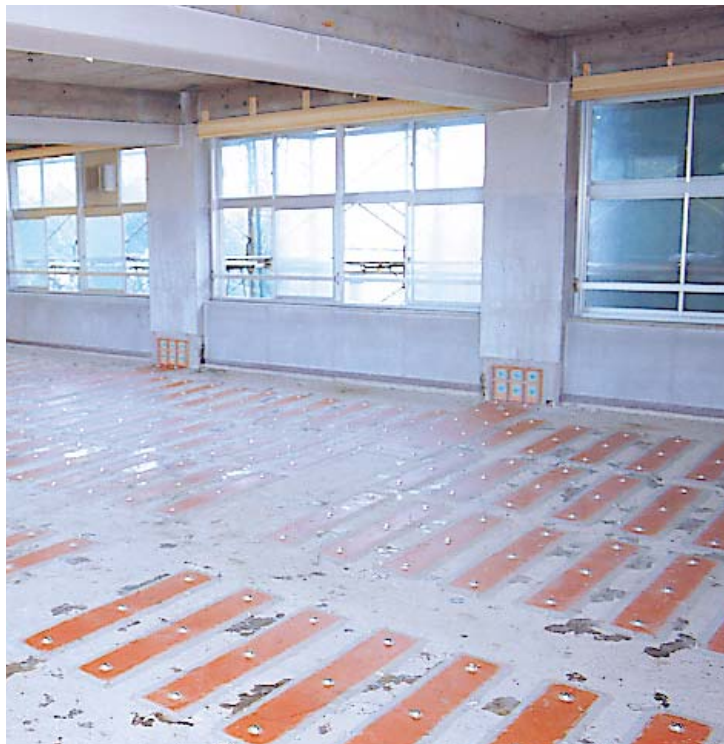
スラブ上面の鋼板接着補強
