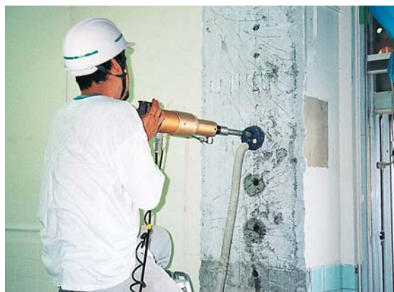
あと施工アンカー穿孔
