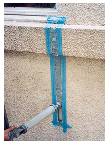
シーリング材の充てん
