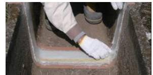
③HBテープの貼付け
