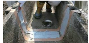
②貼付け用接着剤の塗布
