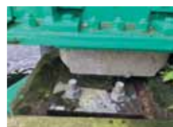
■令和6年度 能登半島地震後の橋梁耐震構造の効果確認を金沢大学・大日本ダイヤCと共同研究と実施
