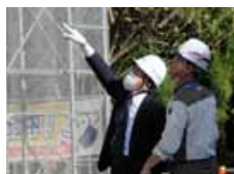
▲無機研究棟建設工事を視察する岸本社長(当時)
