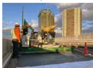
◀LSF 施工状況
