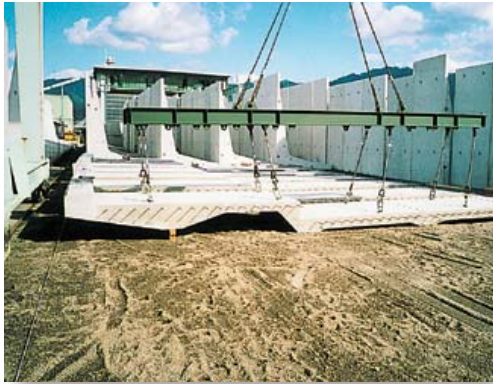
①スーパー床版製作
