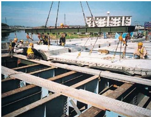
③スーパー床版の架設
