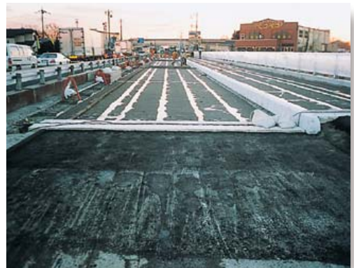
⑤橋面防水
