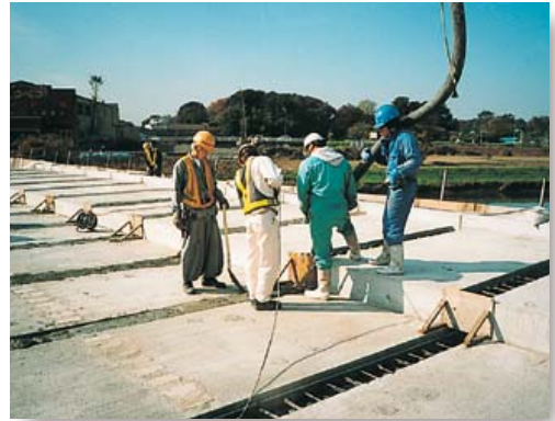
④継手部の配筋・打設
