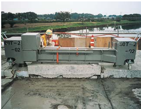
②既設床版の解体・撤去
