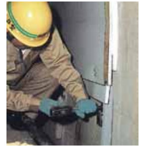
▲アンカー打込み
