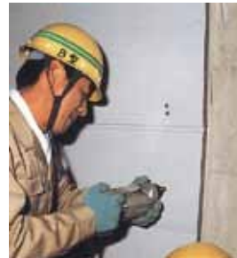
▲テクスボルトの打込み
