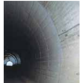
▲完成(設置端部)
