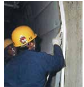
▲SIボード設置
