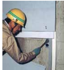
▲取付け金具の設置
