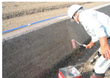
2. AGプライマー塗布
