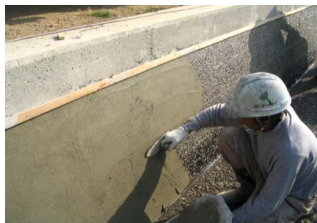
3. AGモルタルによる断面修復
